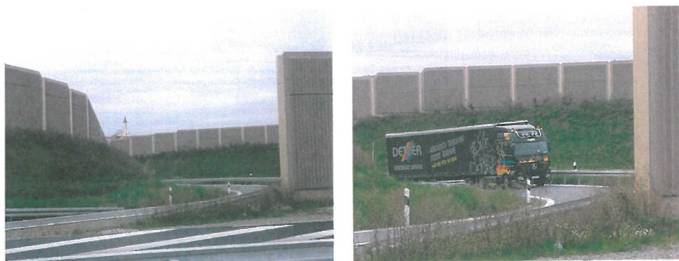
Die Elemente verfügen über Höhen von bis zu 3,75 m und entsprechen der Lärmschutzkategorie „Lärmdämmend und Lärmabsorbierend bzw. Hochabsorbierend“
